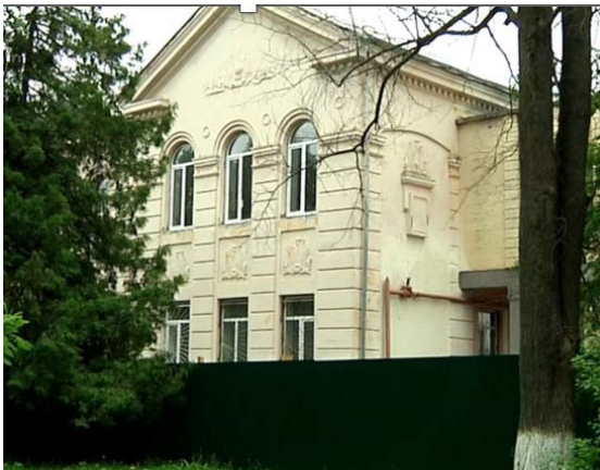
в) Об'єкт 3. «Реконструкція будівлі школи 23»
